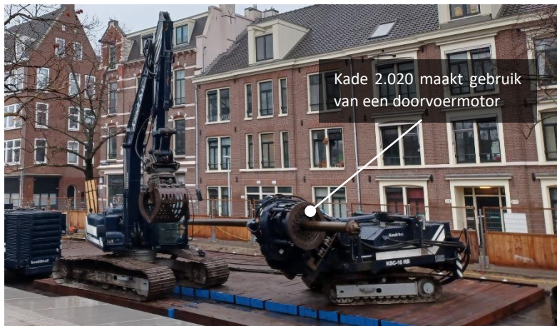
Figuur 8: Heistelling met doorvoermotor
