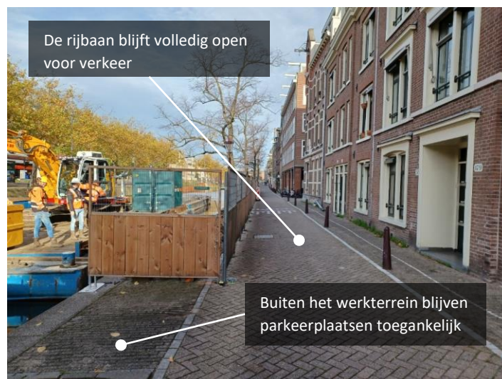
Figuur 10: Uitvoering werkzaamheden t.p.v. de Lijnbaansgracht.
