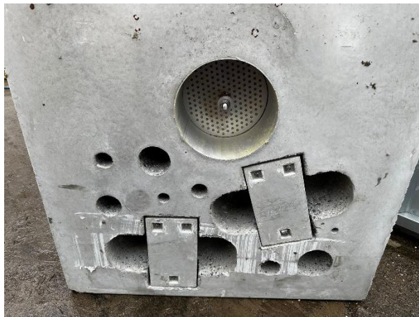
Figuur 12: Foto van de voorzieningen in het betonelement. De bovenste sparing verzorgt de waterdoorlatendheid.
